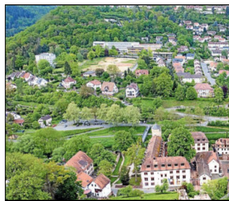
Die Wertheimer Grundschule soll auf den Standort ziehen, an dem 2019 das Krankenhaus abgerissen wurde. Foto: Janek Mayer
