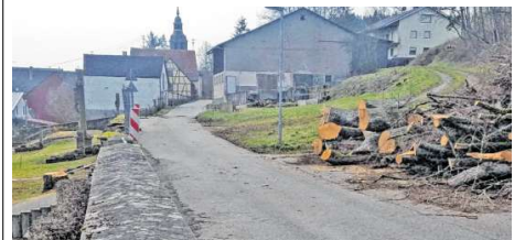
2017 war ein Teil der historischen Friedhofsmauer in Erfeld eingestürzt. Die komplette Mauer soll saniert werden.
