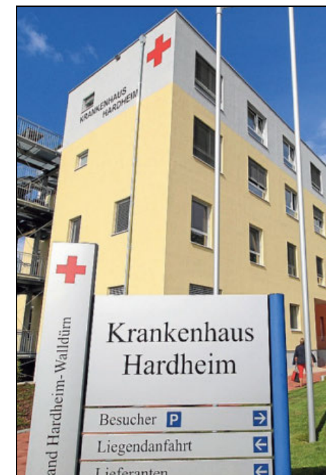
Die Fallzahlen sind am Krankenhaus Hardheim im Jahr 2019 trotz der Bauarbeiten für die Erweiterung gestiegen. Foto: Rüdiger Busch
