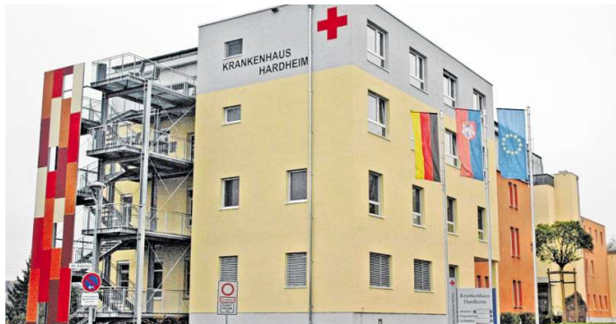
Der Krankenhausverband Hardheim-Walldürn setzt mit dem gelungenen Umbau und dem Wirtschaftsplan 2020, der in der Verbandsversammlung im Refektorium des Hardheimer Krankenhauses verabschiedet wurde, ein positives Signal für die Zukunft des Hauses.
