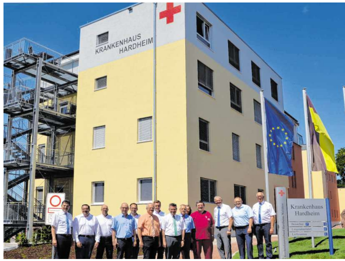
Große Freude herrschte am Sonntag in Hardheim über die gelungene Aufwertung Krankenhauses durch mehrere Erweiterungsbauten bei deren offizieller Übergabe.
