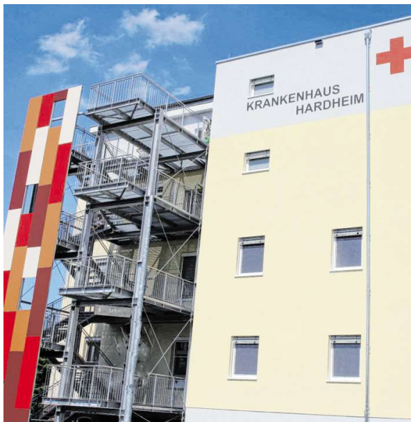
Hingucker: Die bunte Verkleidung des Fluchttreppenhauses am Krankenhaus Hardheim. BILD: INGRID EICHRICH-SCHAAB
