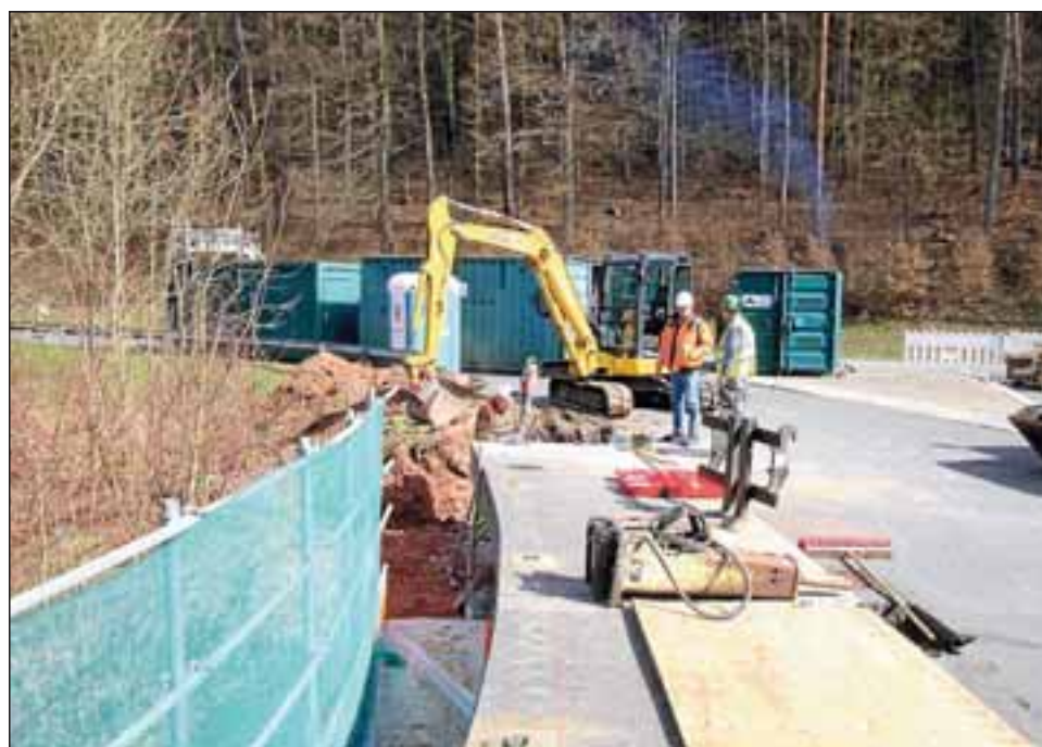
Seit zehn Tagen laufen die Arbeiten zur grundlegenden Sanierung der Erftalbrücke bei der „Wohlfahrtsmühle“. Alle Fotos: Rüdiger Busch
