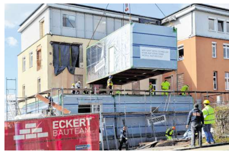
Die Erweiterung des Hardheimer Krankenhauses geht weiter: Ein großer Autokran hievte gestern die ersten sechs von insgesamt 16 Raummodulen von der Wertheimer Straße über den Ackerleinsgraben an ihren Bestimmungsort vor der internistischen Praxis des Krankenhauses. In drei Tagen soll der neue Anbau stehen. BILDER INGRID ERICH-SCHAAB
