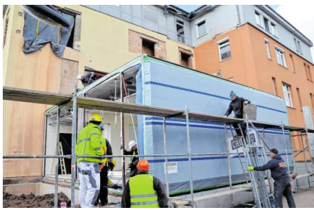
Die Erweiterung des Hardheimer Krankenhauses geht weiter: Ein großer Autokran hievte gestern die ersten sechs von insgesamt 16 Raummodulen von der Wertheimer Straße über den Ackerleinsgraben an ihren Bestimmungsort vor der internistischen Praxis des Krankenhauses. In drei Tagen soll der neue Anbau stehen. BILDER INGRID ERICH-SCHAAB
