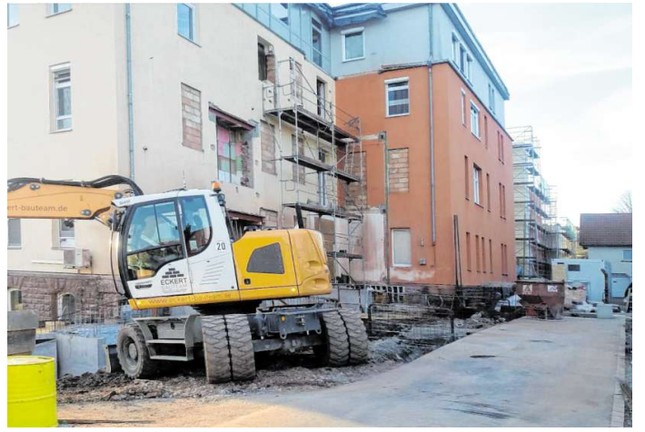
Am Hardheimer Krankenhaus werden zurzeit die Beton- und Fundamentarbeiten für den Anbau eines neuen Bettentraktes getätigt. Die 16 Module hierfür sollen am 19. März angeliefert und aufgestellt werden. BILD: LUDWIG SCHÖN
