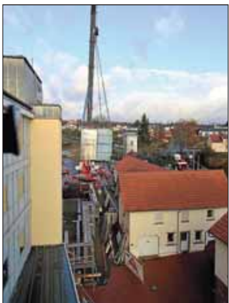
Die Präzisionsarbeit im Zeitraffer: Der Kran hebt die rund 20 Tonnen schweren Raummodule vom im Triebweg abgestellten Tieflader, lüpft sie über die Rettungswache und bugsiert sie an den Standort an der chirurgischen Praxis.
