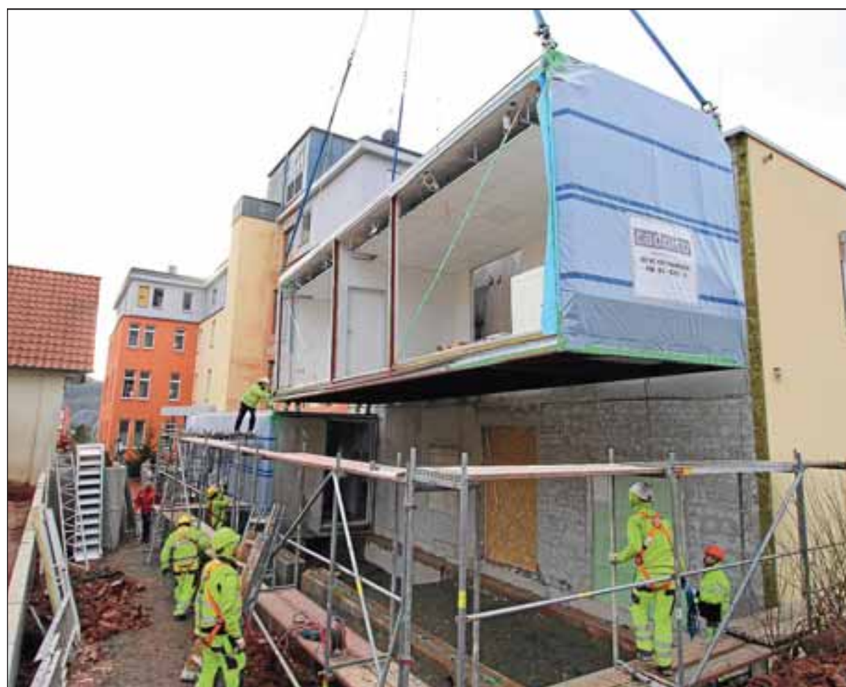
Millimeterarbeit war am Dienstag beim Aufbau der Module für die Erweiterung des Hardheimer Krankenhauses gefragt. Alle Fotos: Rüdiger Busch
