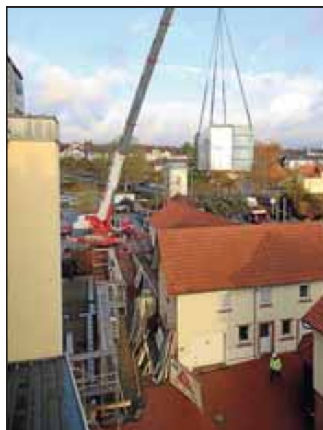
Die Präzisionsarbeit im Zeitraffer: Der Kran hebt die rund 20 Tonnen schweren Raummodule vom im Triebweg abgestellten Tieflader, lüpft sie über die Rettungswache und bugsiert sie an den Standort an der chirurgischen Praxis.
