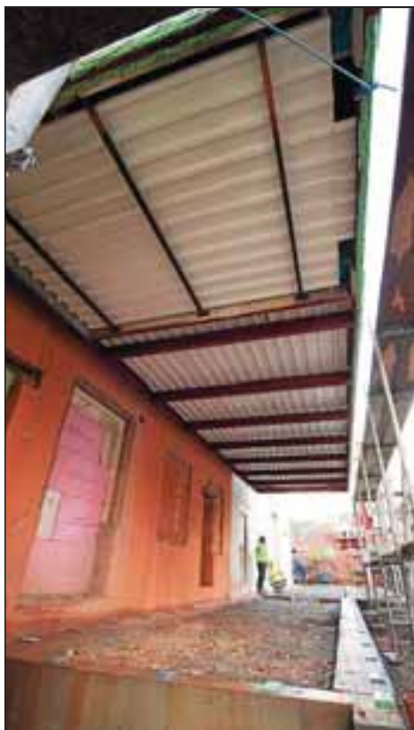
Wie Legosteine werden die Module aufs Fundament aufgesteckt.
