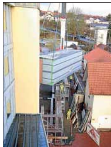
Die Präzisionsarbeit im Zeitraffer: Der Kran hebt die rund 20 Tonnen schweren Raummodule vom im Triebweg abgestellten Tieflader, lüpft sie über die Rettungswache und bugsiert sie an den Standort an der chirurgischen Praxis.
