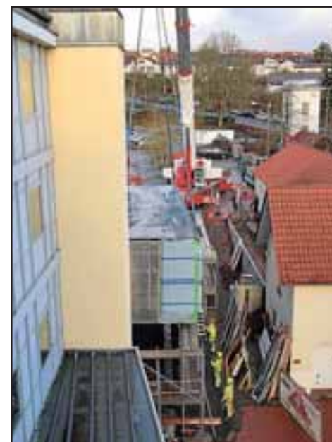
Die Präzisionsarbeit im Zeitraffer: Der Kran hebt die rund 20 Tonnen schweren Raummodule vom im Triebweg abgestellten Tieflader, lüpft sie über die Rettungswache und bugsiert sie an den Standort an der chirurgischen Praxis.
