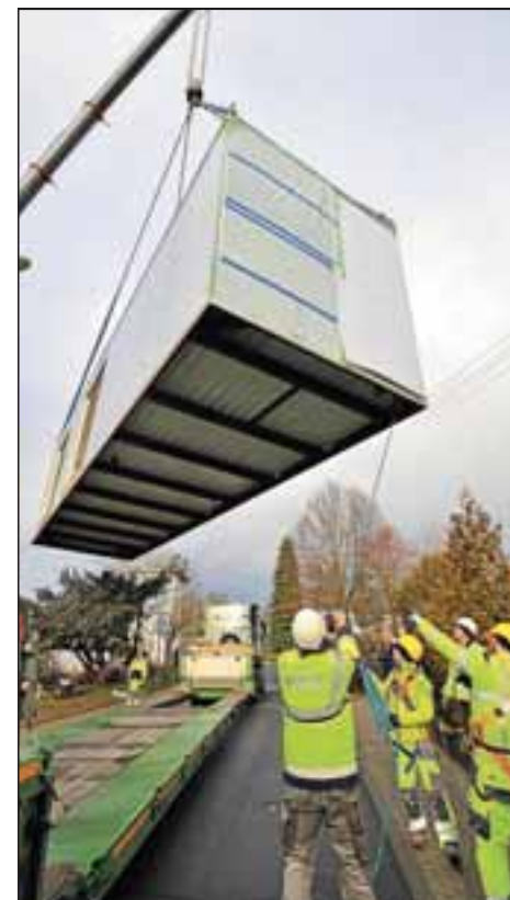
Achtung: Hier kommt ein neues Zimmer angefliegen!
