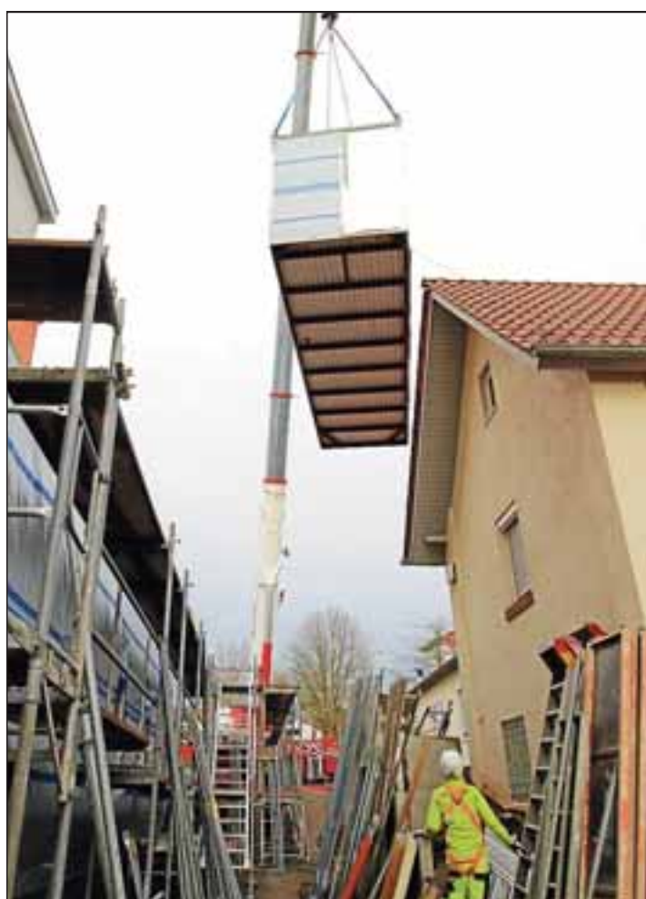
Millimeterarbeit war am Dienstag beim Aufbau der Module für die Erweiterung des Hardheimer Krankenhauses gefragt. Alle Fotos: Rüdiger Busch
