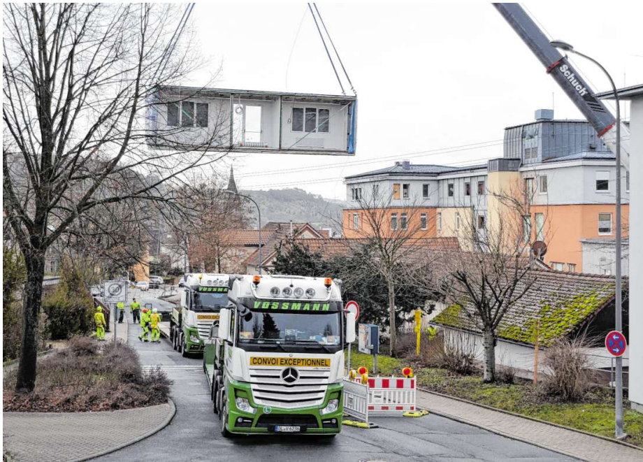
Ein für bis zum 250 Tonnen ausgelegter Autokran hievte die Module vom Triebweg aus über die Rettungswache hinweg an ihren Bestimmungsort.
