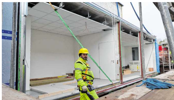
Blick in das Modul mit dem neuen Eingangsbereich der chirurgischen Praxis (links). Rechts ist das Ansetzen des zweiten Moduls an das bestehende Gebäude zu sehen.
