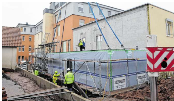
Blick in das Modul mit dem neuen Eingangsbereich der chirurgischen Praxis (links). Rechts ist das Ansetzen des zweiten Moduls an das bestehende Gebäude zu sehen.
