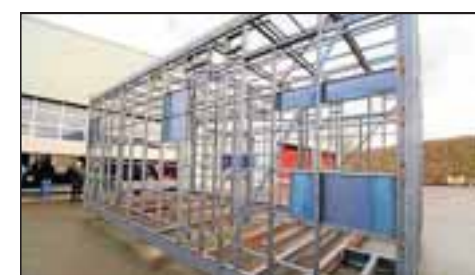
Aus dieser Stahlkonstruktion wird später einmal ein Patientenzimmer.
