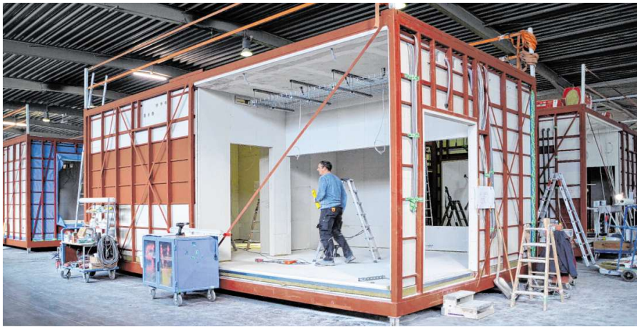
Ein Krankenzimmer in Modulbauweise. Das Stahlgerüst hat eine 30er Lattung, in der die stabilen Fermacell-Ausbauplatten festgeschossen werden. BILD: INGRID ERICH-SCHAAB
