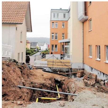
Baufortschritt: Die Leitungsarbeiten wurden bereits angegangen.
