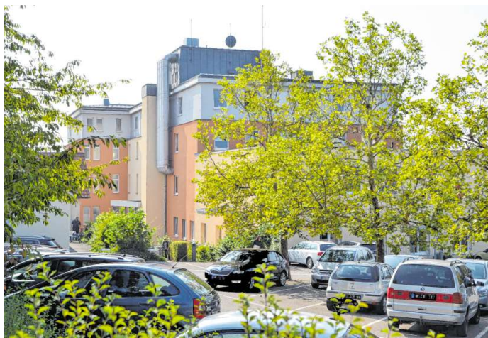
Während der Bauphase wird es erhebliche Parkprobleme am Hardheimer Krankenhaus geben, da bestehende Parkflächen gesperrt werden müssen. Vorübergehend werden Ersatzparkplätze in nahe gelegenen Wohnstraßen ausgewiesen. BILD: INGRID EIRICH-SCHAAB
