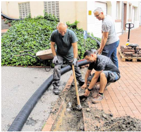
Nach der Verlegung des neuen Stromkabels seit Donnerstag (Bild) wird dieses heute angeschlossen. BILD: KRANKENHAUSVERWALTUNG HARDHEIM
