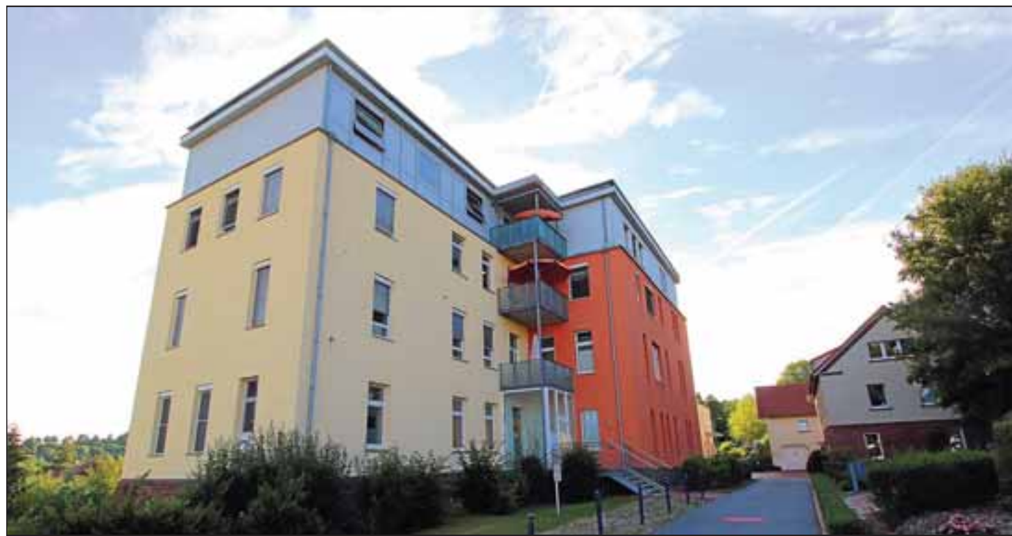
Ab September eine Baustelle: Der Gemeinderat genehmigte den millionenschweren Erweiterungsbau des Krankenhauses. Foto: Rüdiger Busch
