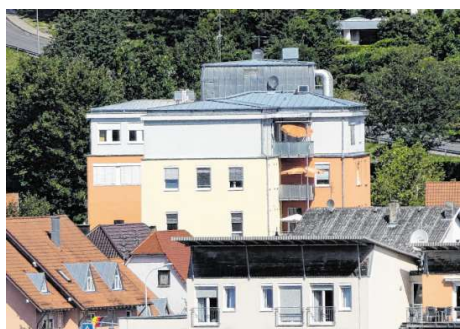
Blick auf das Hardheimer Krankenhaus aus einer ungewohnten Perspektive. Auf der rechten Seite entstehen die Anbauten. BILD: INGRID ERICH-SCHAAB
