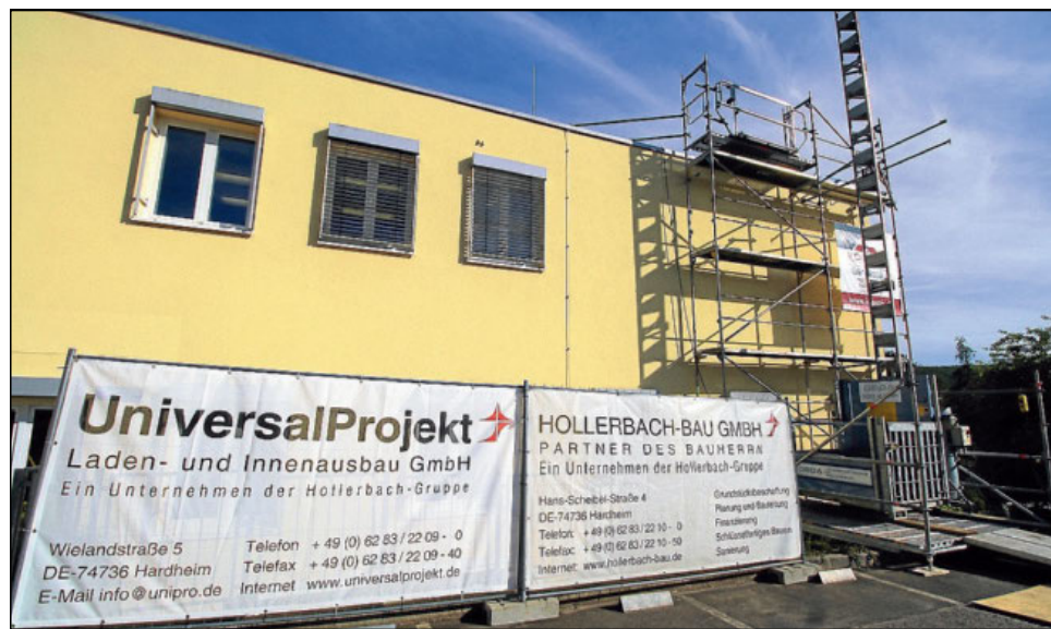
Ein Baustellenaufzug stellt sicher, dass der Umbau der gynäkologischen Praxis den Krankenhausbetrieb möglichst wenig beeinträchtigt.
