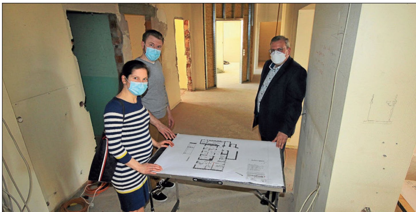
Baustellenbesuch: Vera Schoeder, Martin Teichmann und Lothar Beger (r.) informierten sich, wie weit die Neugestaltung der gynäkologischen Praxis am Hardheimer Krankenhaus bereits fortgeschritten ist. Foto: Krankenhausverband Hardheim-Walldüren
