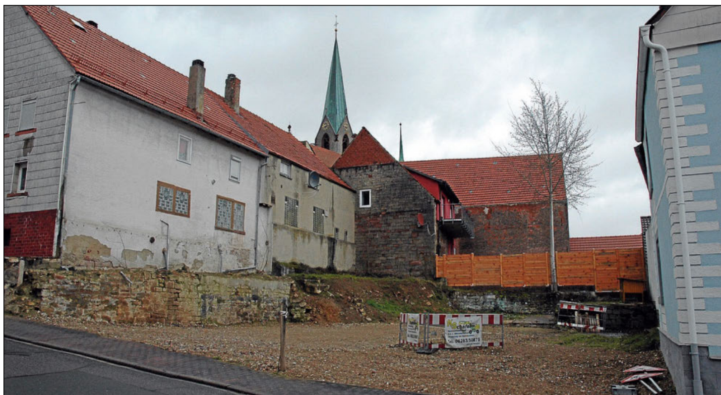
Nachdem Bagger im August 2019 zwei leerstehende Häuser in der Oberen Hauptstraße abgerissen haben, sollen dort nun noch in diesem Jahr die Bauarbeiten für ein Mehrfamilienhaus mit 14 seniorengerechten Wohnungen beginnen. Foto: Adrian Brosch
